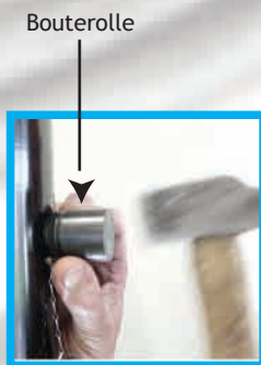
MISE EN PLACE DE LA BASE
